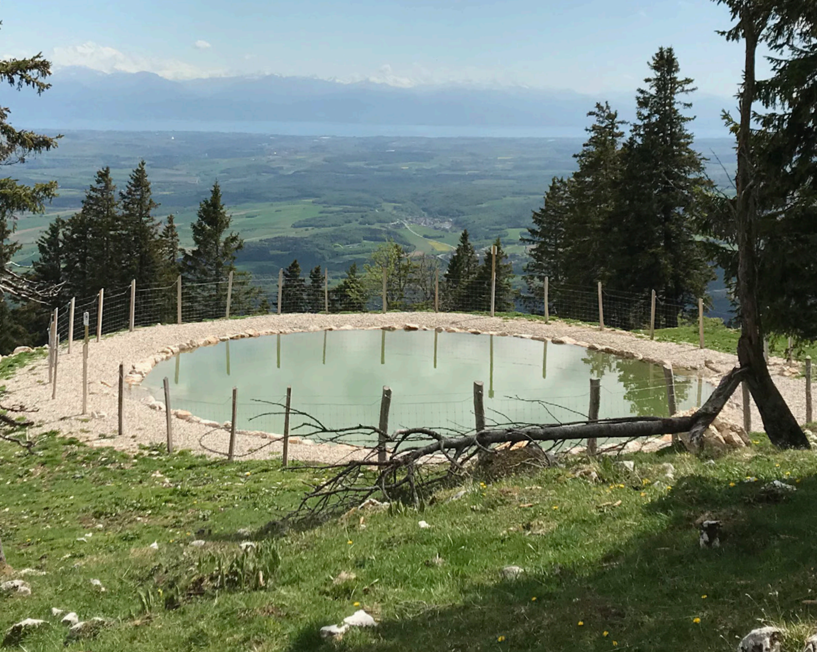
Bassin de stockage d'un volume de 250 m 3
