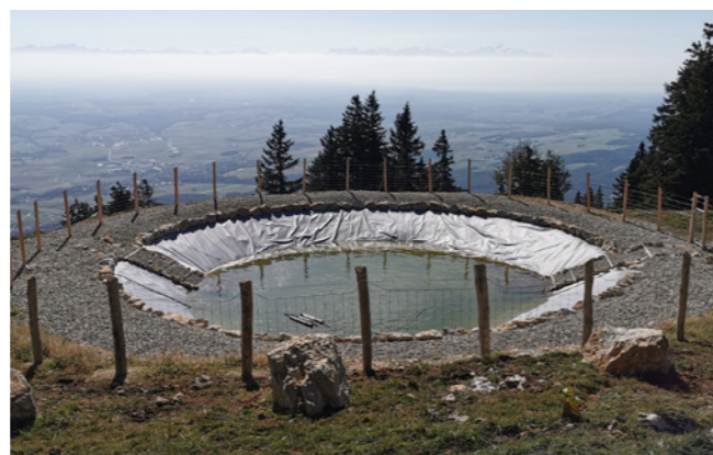
Bassin de stockage d'un volume de 250 m 3
