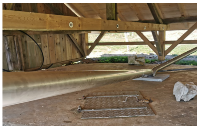
Collecte de l'eau du toit dans une citerne
