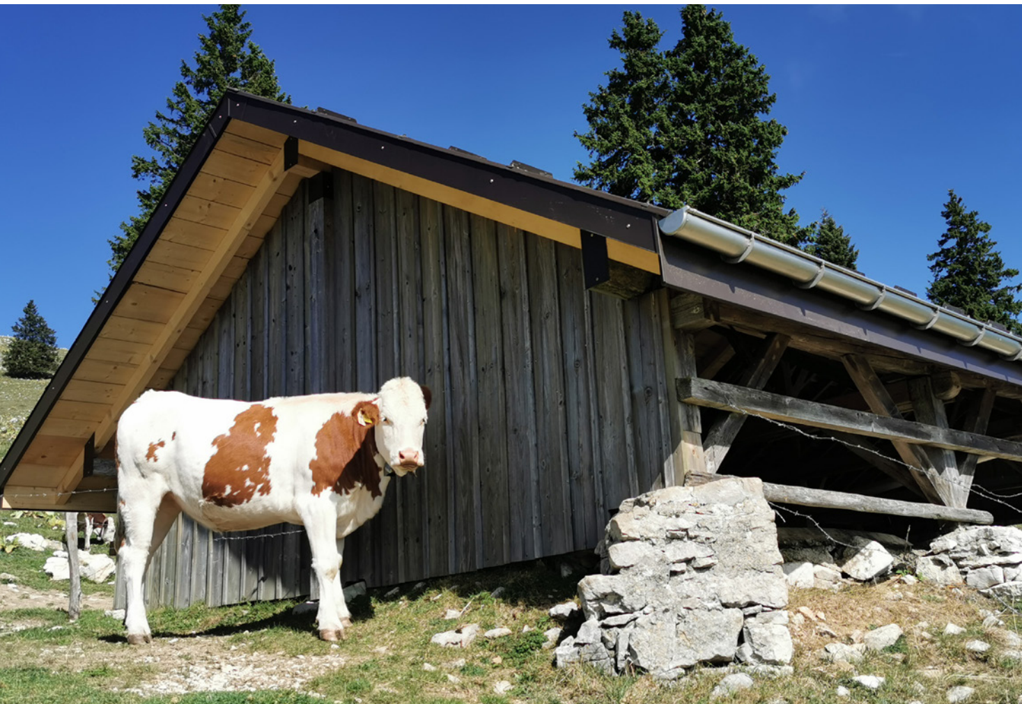
Nouvelle construction du toit pour remplir la citerne
