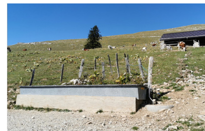
Approvisionnement de l'abreuvoir par l'eau du toit
