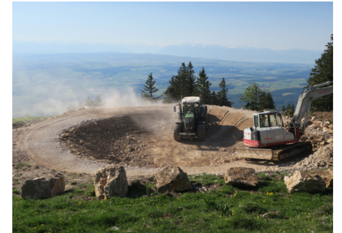
Travaux de terrassement pour le bassin de stockage
